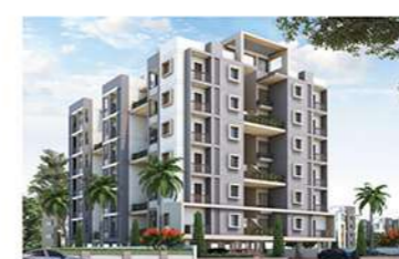
VEDANT GARNET New Sahakar Nagar
